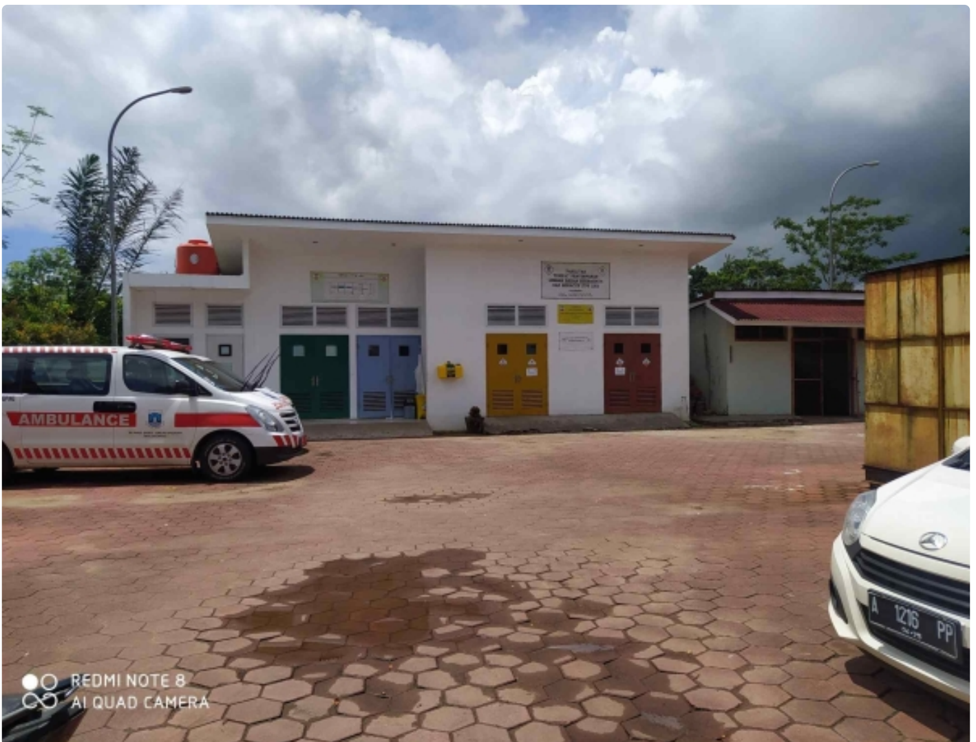
Ruang/gedung instalasi TPSL B3 RSUD Malingping
